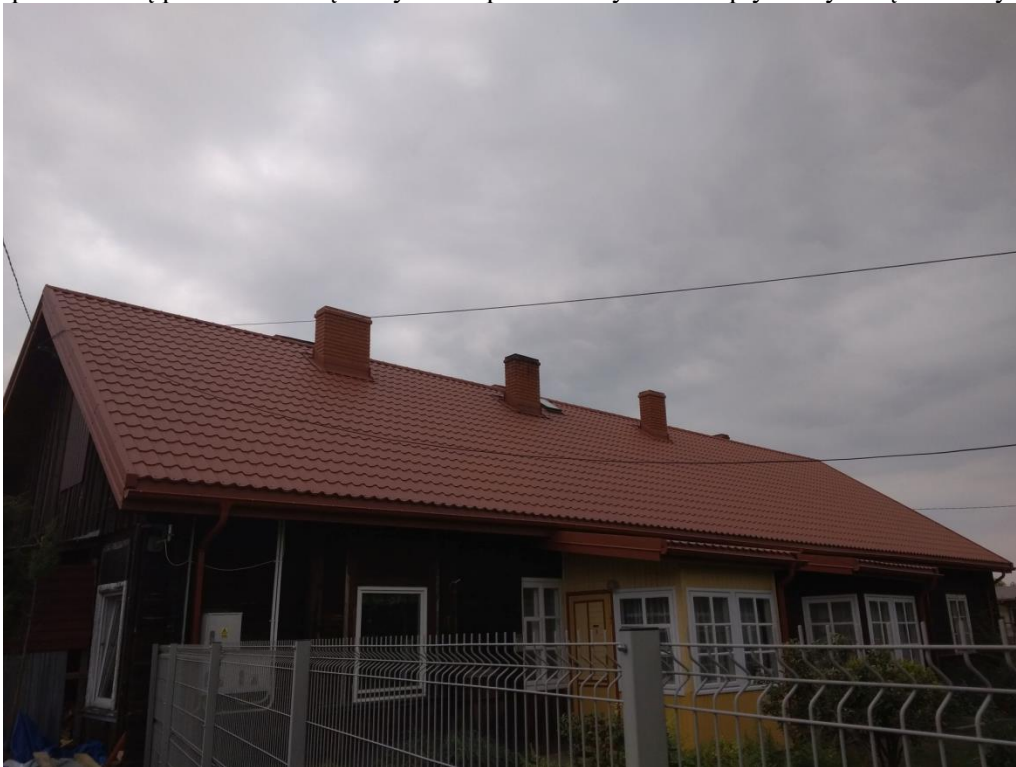
Dach na którym planowana jest inwestycja
